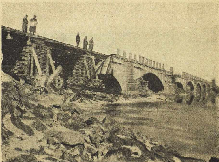
Сивашский желдор. мост, взорванный белыми и временно наведенный Красной армией.
