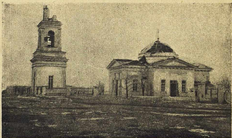
Перекопский собор, разрушенный белыми.
